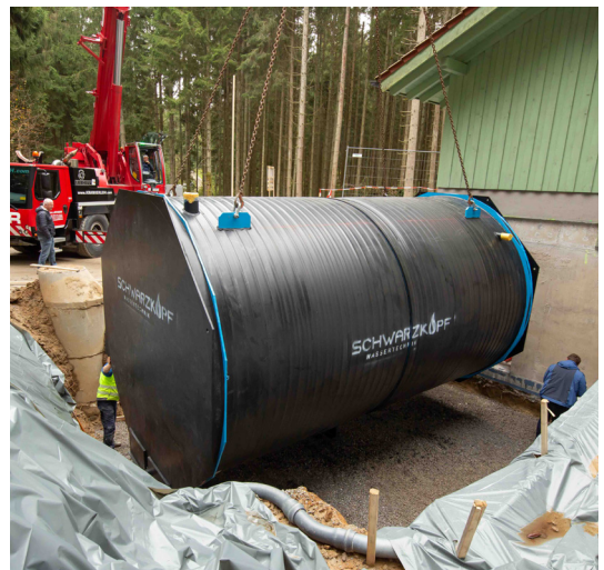
El traslado en grúa del pozo de PE de Schwarzkopf Wassertechnik a su nueva ubicación.
